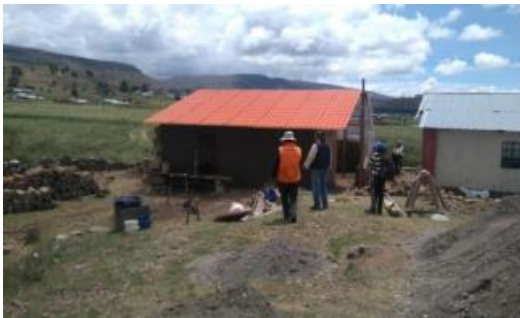
Figura 7. Trabajo de obras de la Comunidad La Rinconada.
